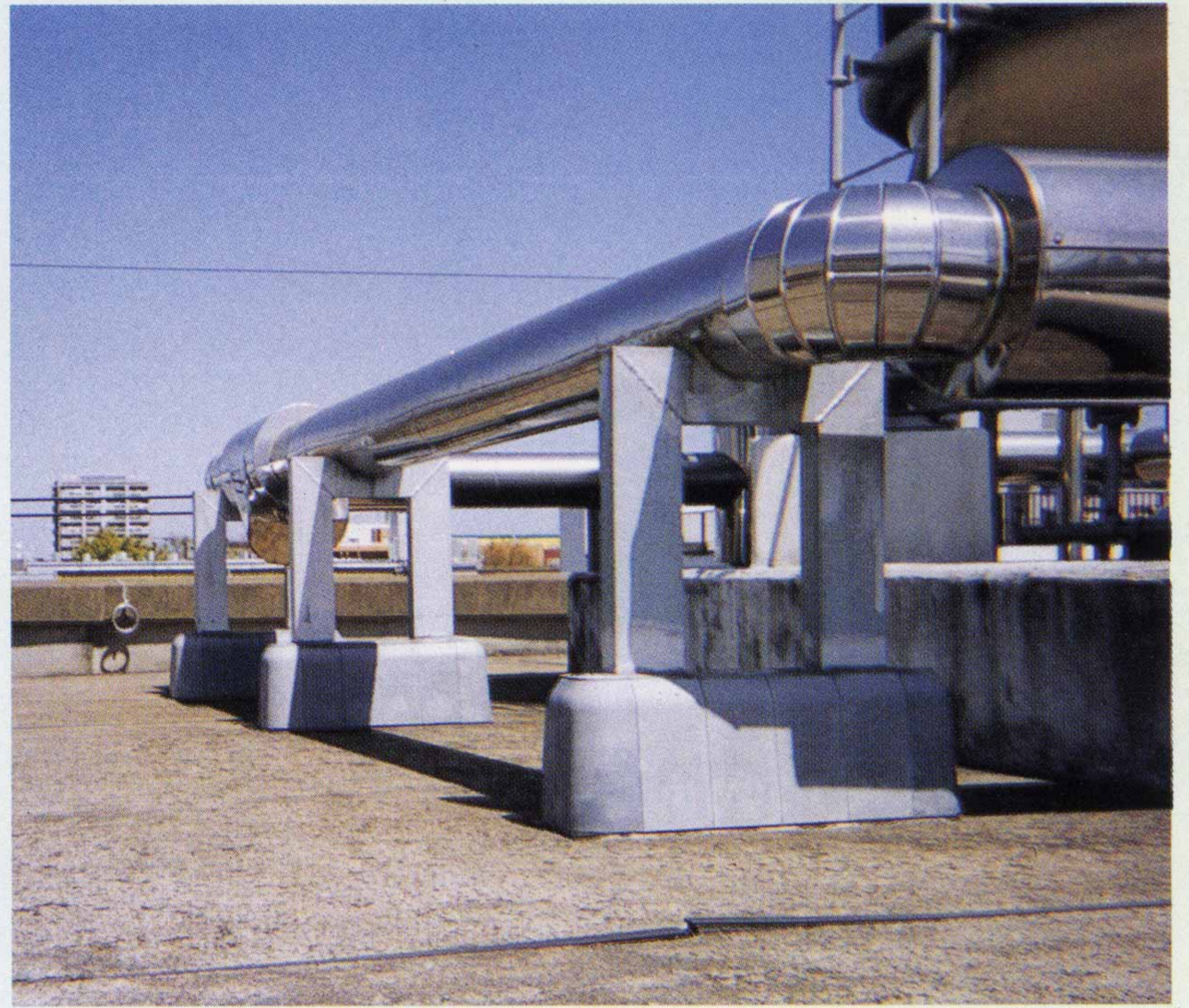
川口市役所教育局屋上 高さ300mmのポリマーブロックにジョイントを使用して施工
